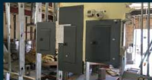
COLOCACIÓN DE CENTROS DE CARGA
