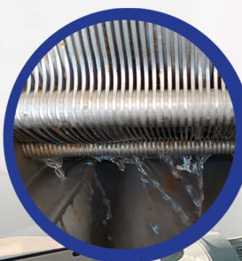
Descarga do efluente clarificado
