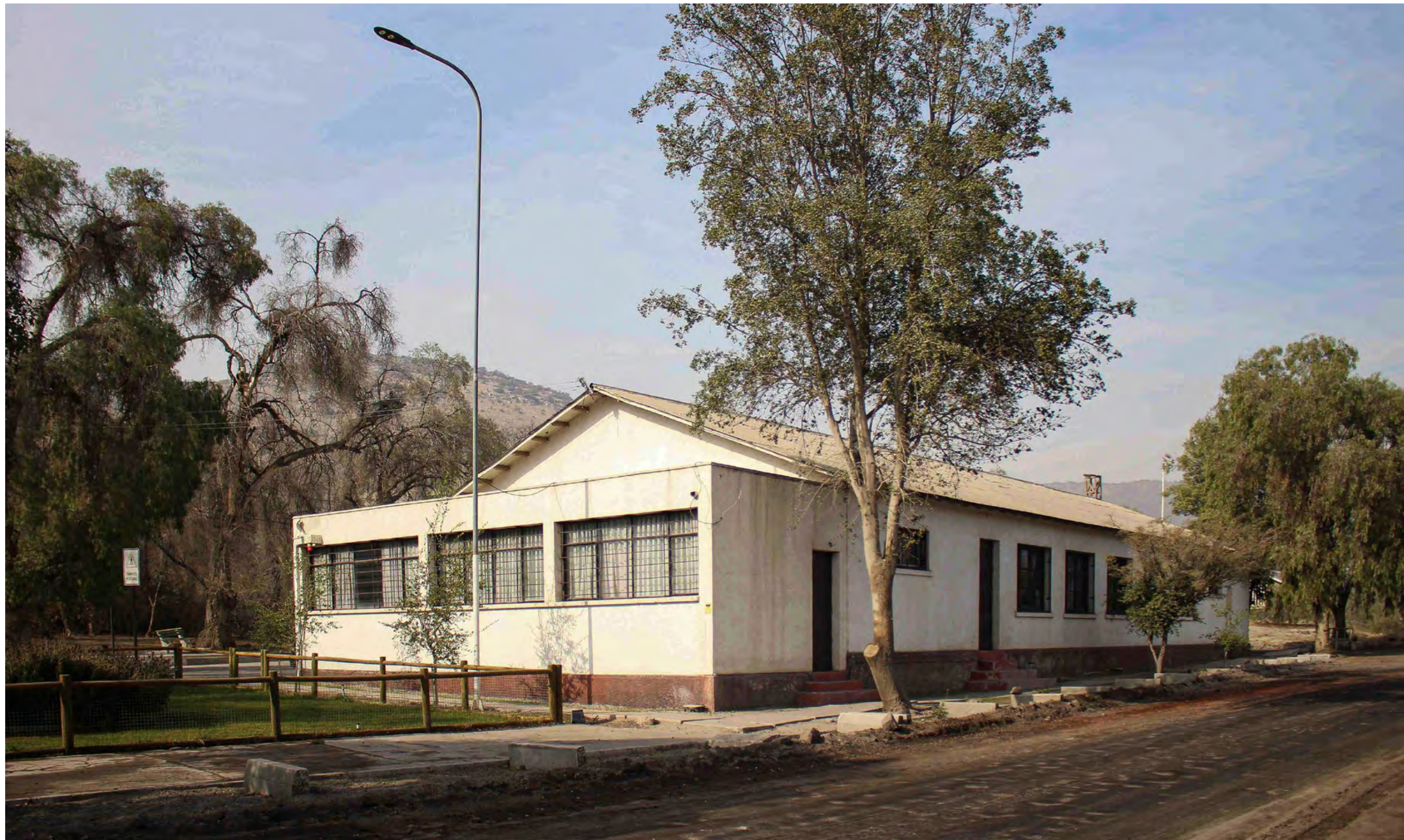
← Fig. 37 Edificio de Sindicato n.º 1.
